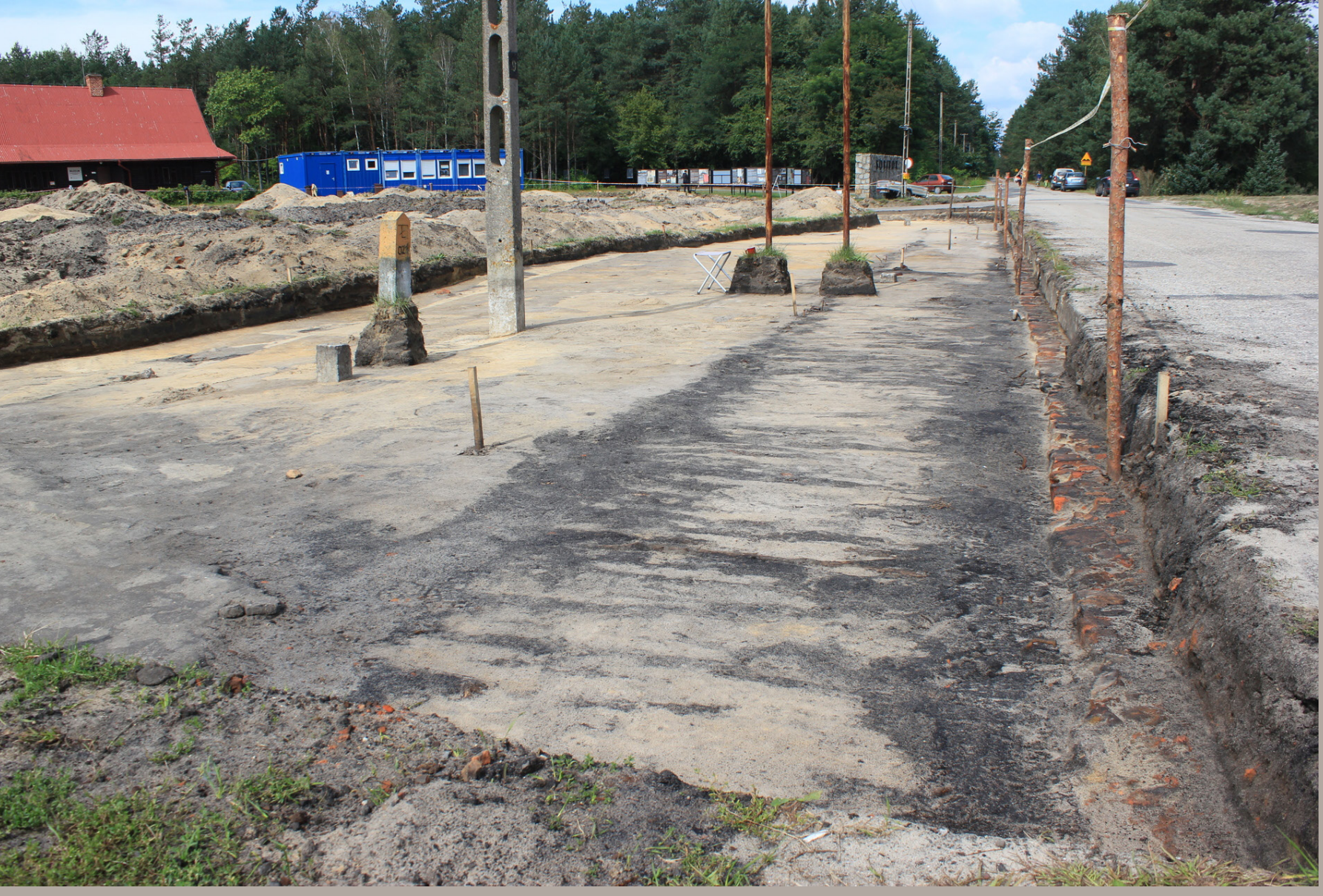
Sobibór: Archäologische Ausgrabungen im Bereich der Rampe, 2014 Von Julian Njica - Eigenes Werk, CC BY-SA 4.0, https://commons.wikimedia.org/w/index.php?title=40663808
